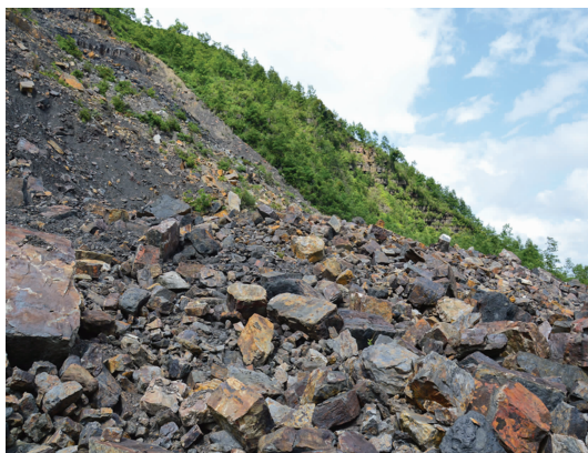
图 4 滑坡后缘崩塌体(镜向 30°)
