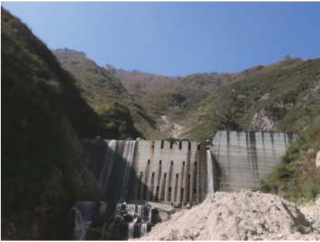
图 4 坝肩及坝体完整度较高
