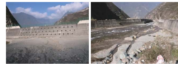
图 7 七盘沟内拦挡工程和排导工程
