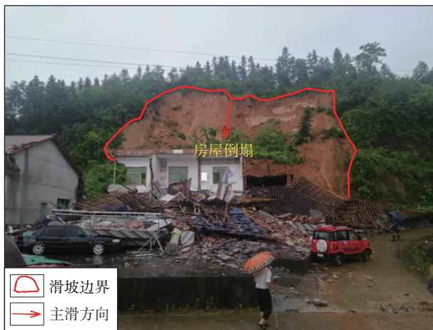
图5 滑坡全貌及倒塌房屋
