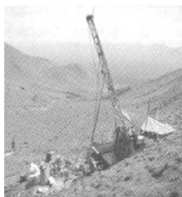
图 1 青海某工地施工现场
