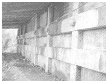
图5 竣工后桥台前墙图
