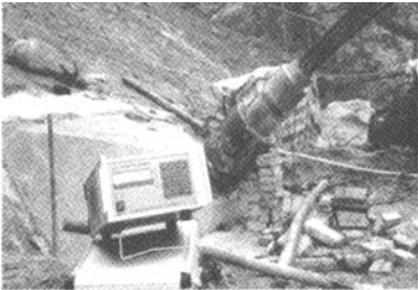
图3 锚索张拉现场测试照片
