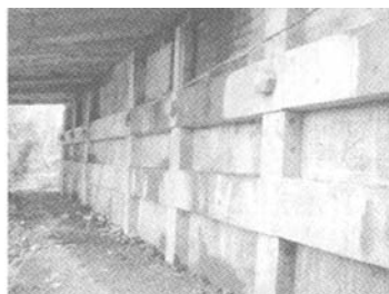
图5 竣工后桥台前墙图
