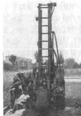
图4 JQL-30型钻机实验现场照片
