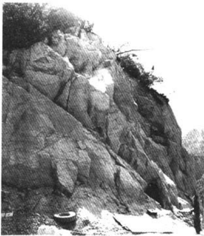
4#边坡中的顺坡向裂隙
