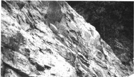
5#边坡中的顺坡向结构面
