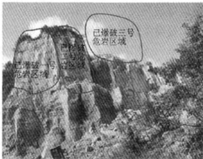
图7 1、2、3号危岩爆破后
