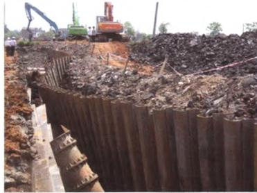
图4 钢板桩变形
