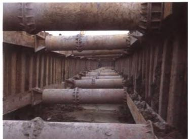
图6 支撑内部结构
