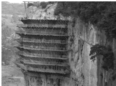
图3 锚索完工后的照片
