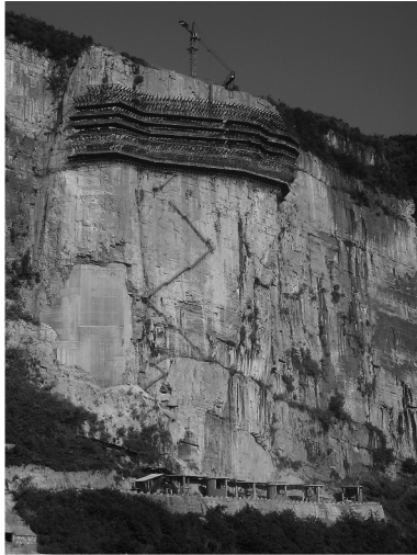
图 1 锚索栈桥照片
