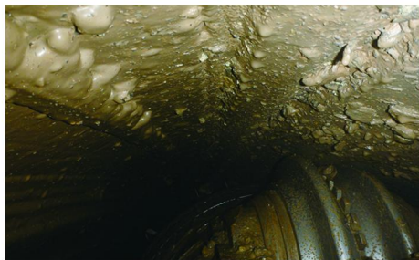
图 2 开仓查刀泥膜图片
