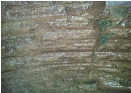
图 3 清渣完成孔壁情况
