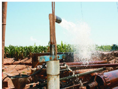
图4 分层抽水采样系统试验现场
