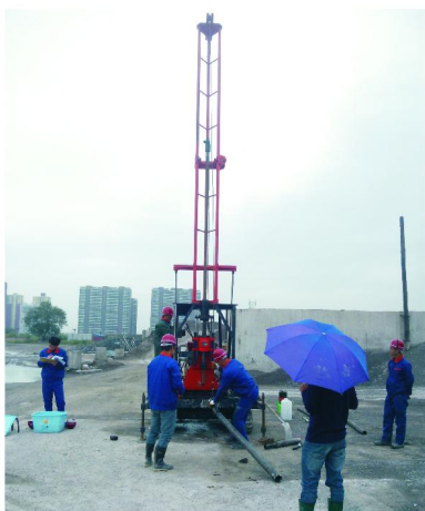
图6 钻机现场施工照片
