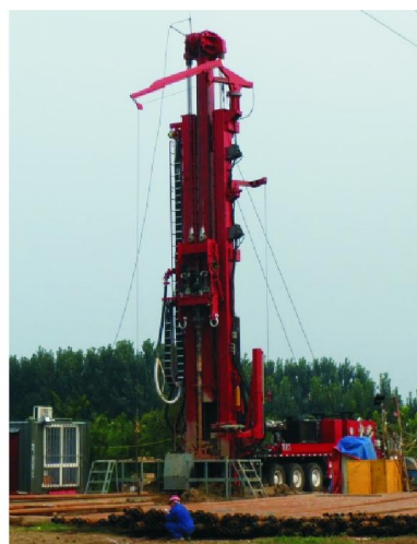
图8 地热井钻探施工现场
