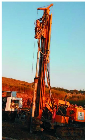
图5 空气潜孔锤钻进工艺
