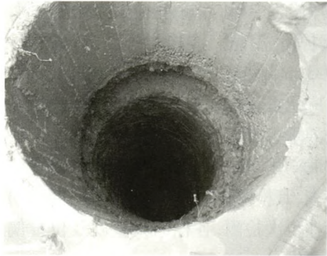
图 1 旋挖钻机第一次钻孔完成
