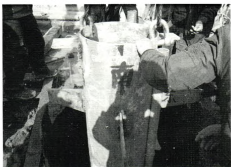
图5 钢管立柱下放
