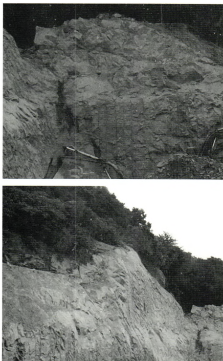
图6 边坡预裂效果图
