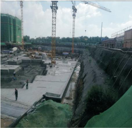
图3 三期基坑支护现场
