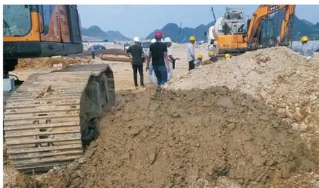
图 3 回填混合土后复打渣土情况
