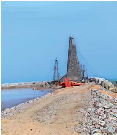
图 2 筑岛式平台施工
